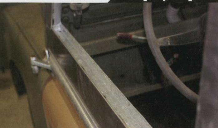
GLANZSTÜCK: Die Tür- und Fensterrahmen wurden feuerverzinkt.
